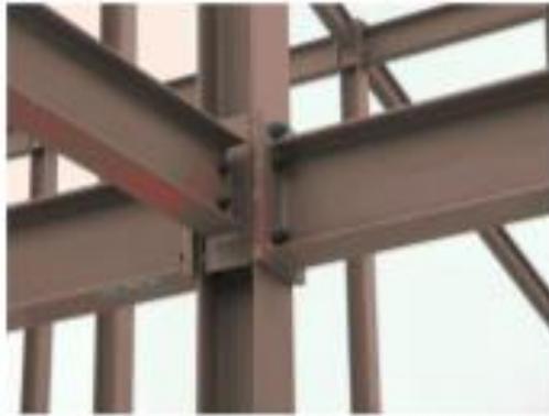
Estructuras en Construcción
